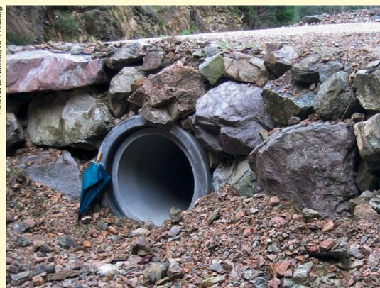
Nur ausreichend dimensionierte Rohrdolnen stellen auch bei Starkregen einen schadarmen Wasserabfluss sicher.
