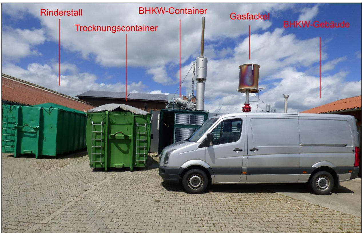
Abbildung 3-5: Aufnahme der Biogasanlage mit Blick nach Norden.
